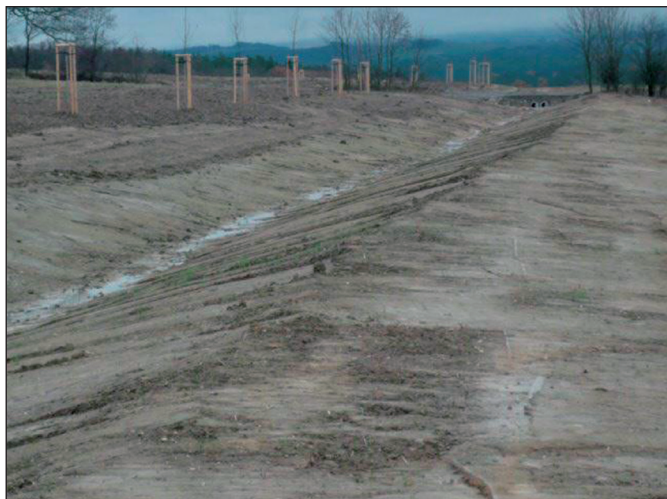
Zasakovací průleh uprostřed svažitého půdního bloku jako ochrana proti bleskovým povodním, které ohrožují zastavěnou část obce, zvyšuje retenci vody v krajině, rozděluje nevhodnou velikost bloku orné půdy a nepřerušovanou délku svahu způsobující erozi půdy. (Hromnice Plzeň sever 2014)
